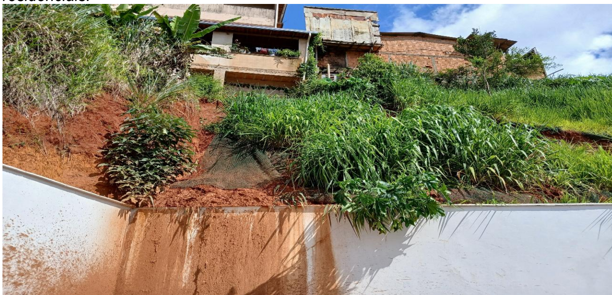
Foto 03 – Evidencia o deslocamento de terra da base de sustentação dos imóveis residenciais.
